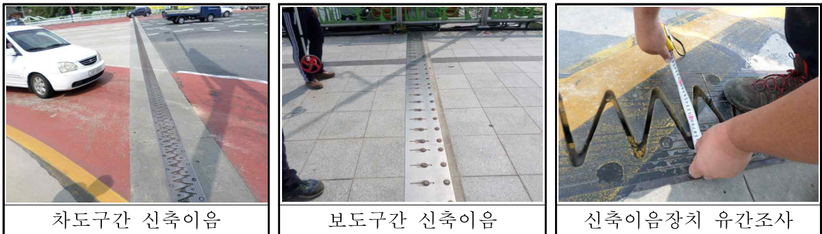
【그림 3.23】 신축이음장치 현황 및 외관조사
