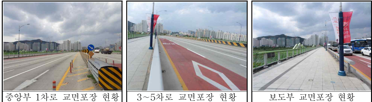
【그림 3.3】 교면포장 현황
