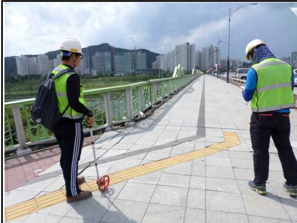
교량상부 외관조사(3인 1조, 도보조사)
